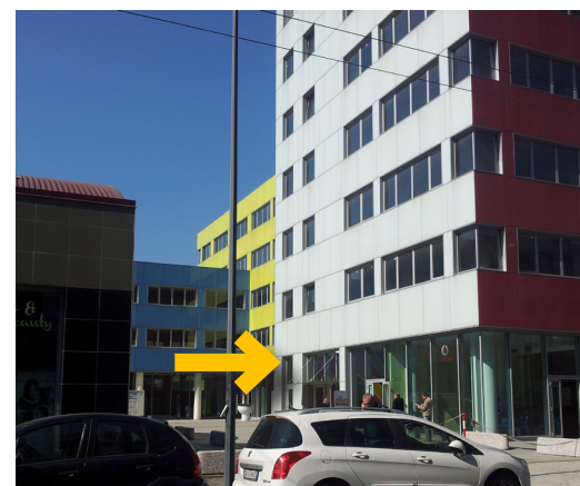
Ingresso da via Durando
